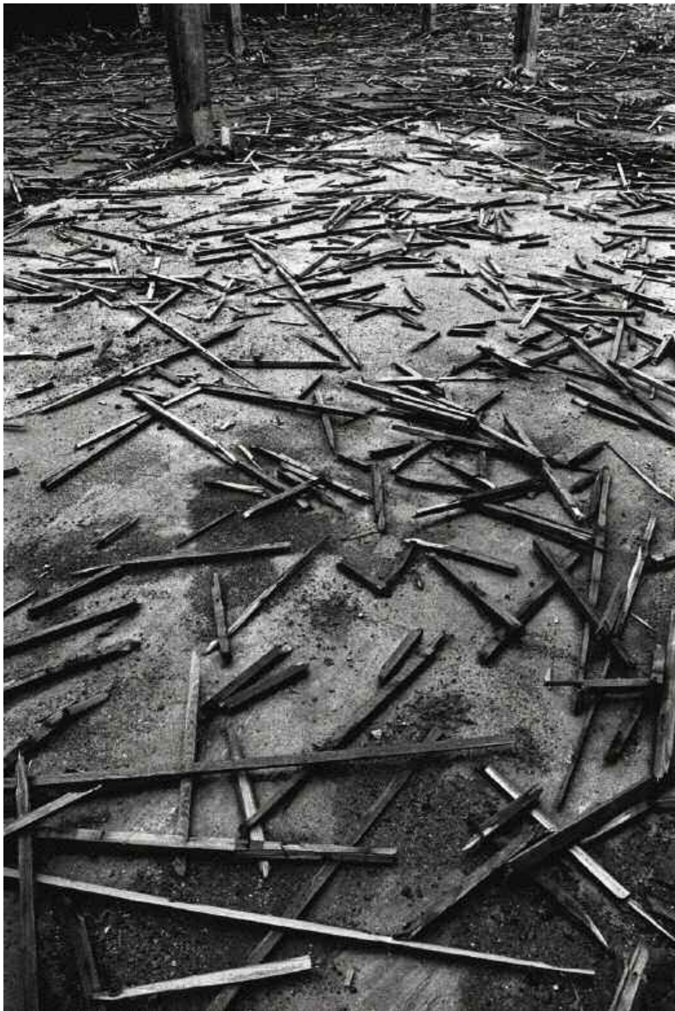
Le chantier du Channel Calais, mardi 9 mai 2006 à 9h58
